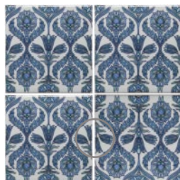
Dit is onjuist, want de patronen aan de zijkanen sluiten niet op elkaar aan, aangezien de tegel rechtsonder ondersteboven is aangebracht
