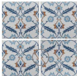
Falsch, da die Muster an den Seiten nicht in einer Linie liegen, weil die Fliese unten rechts auf dem Kopf steht
