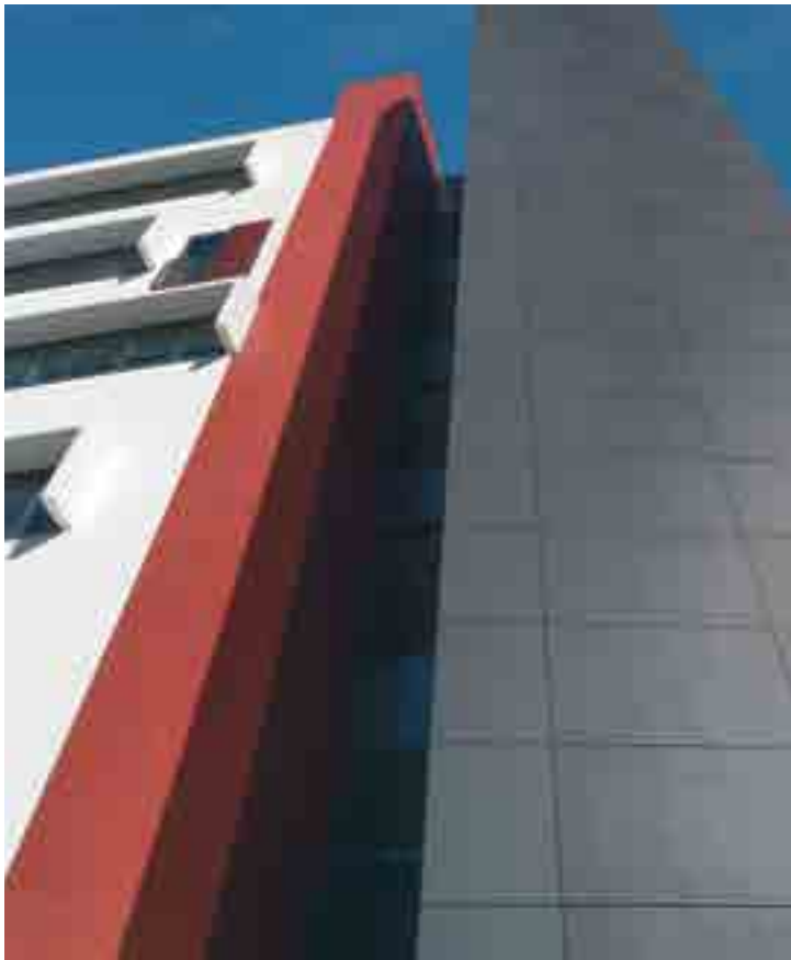
UNA Hotel Modena, Progetto Studio Tiziano Lugli, Facciata Ventilata Marazzi Engineering UNA Hotel Modena, Tiziano Lugli Studio Project, Ventilated Wall Marazzi Engineering
